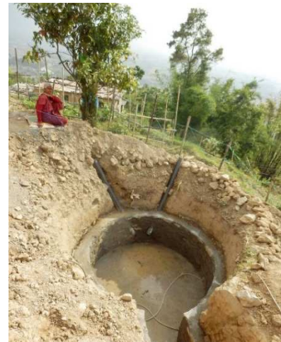
Aufbau einer Biogasanlage | © atmosfair
